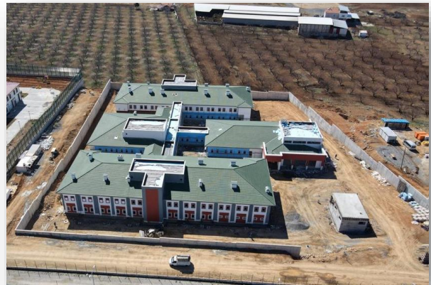
Malatya Geri Gönderme Merkezi İnşaatı
